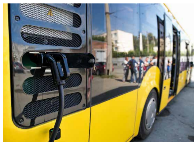
Ein intelligentes Lademanagementsystem wie MOBILEcharge sorgt dafür, dass alle Fahrzeuge bedarfsgerecht, kostengünstig und batterieschonend geladen werden.
